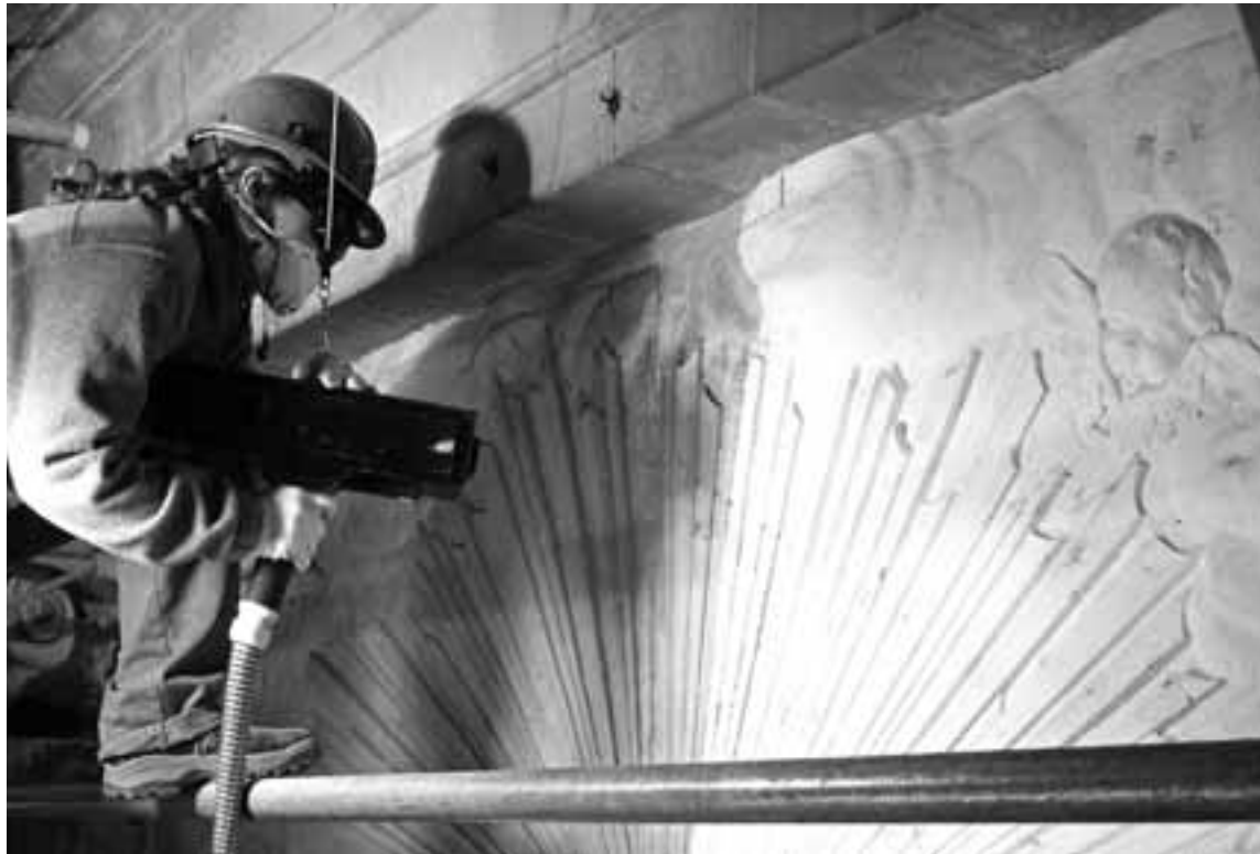
Un técnico interviene con el láser en la fachada, sobre la imagen de la Virgen María.
