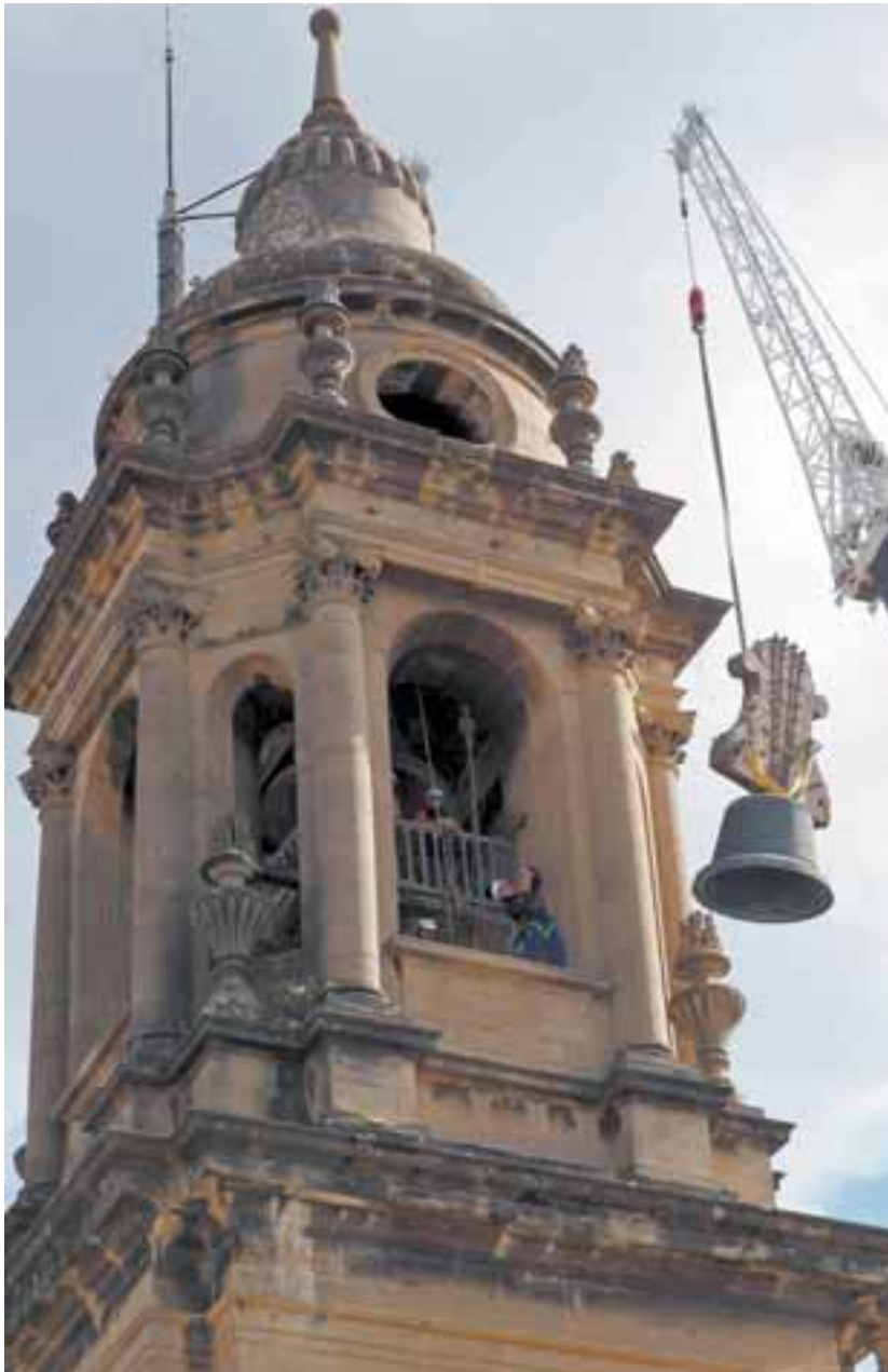
La grúa saca de la torre norte la campana de 'Los cuartos'
