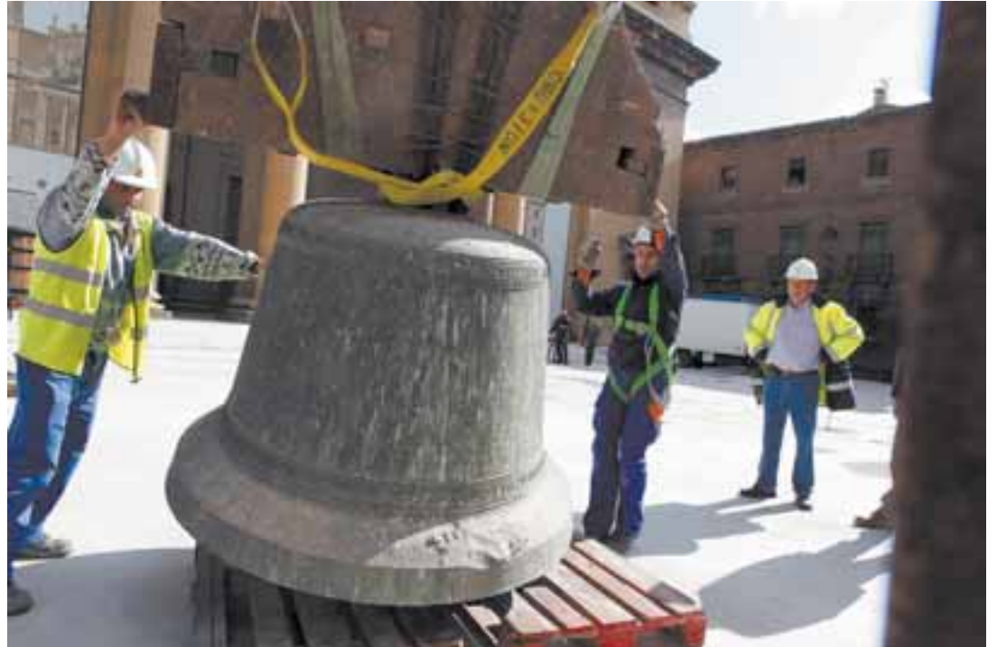
Dos operarios depositan una de las campanas en el suelo.
